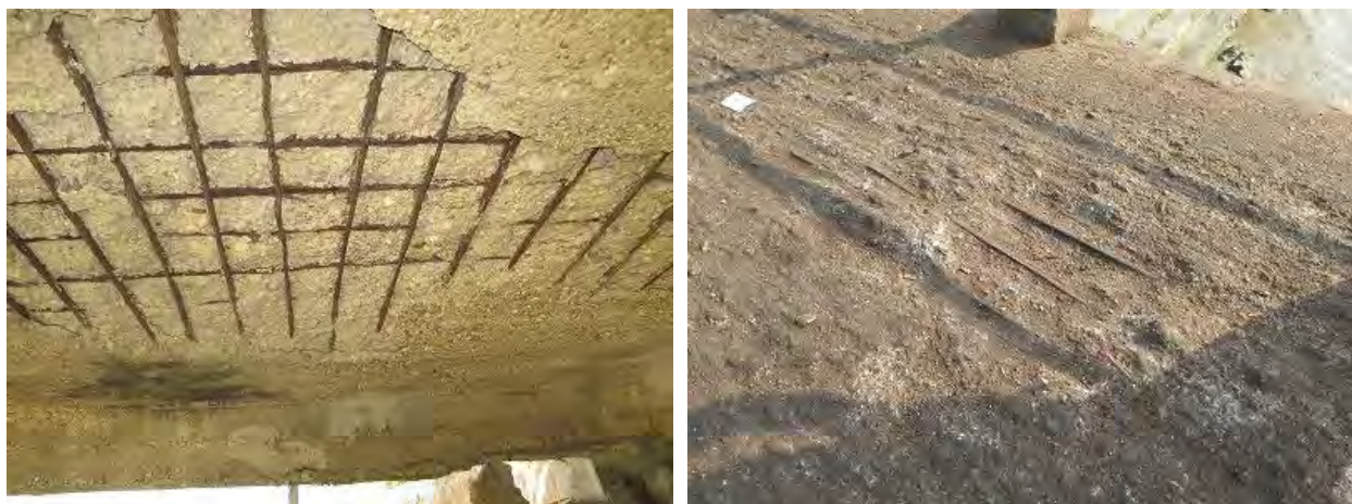
写真 3.6 Sin Oh Dang 1 の損傷箇所（鉄筋露出、左：下面、右：上面）
