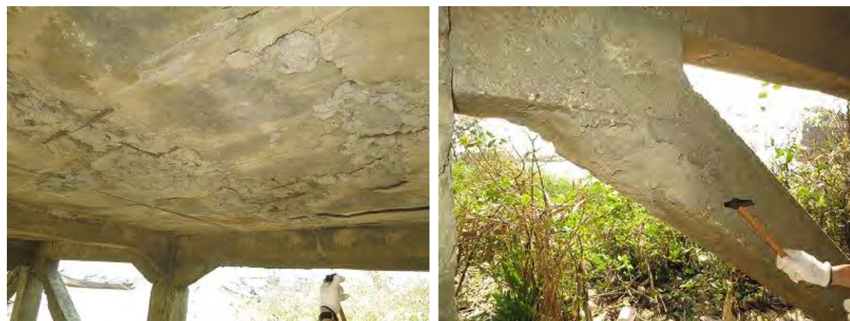
写真 3.12 Kaingdon Jetty 1 下面の補修箇所（再劣化部分）
