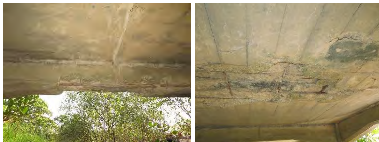
写真 3.10 Hledan 2 下面の損傷状況
