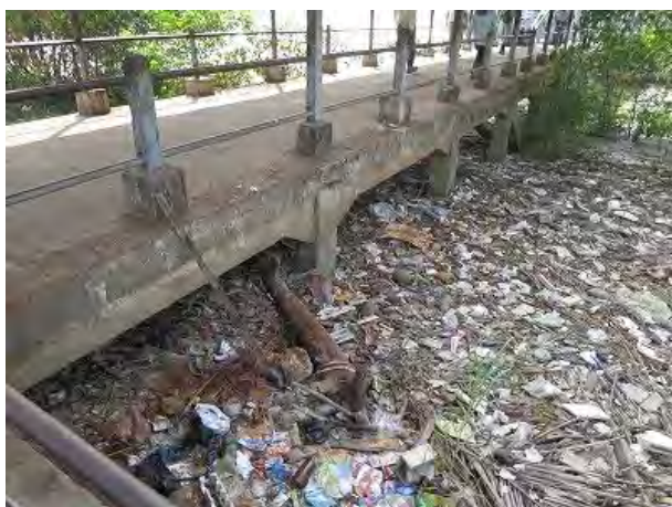
写真 3.14 Wadan Jetty 6 の全景とひび割れ鉄筋露出箇所
