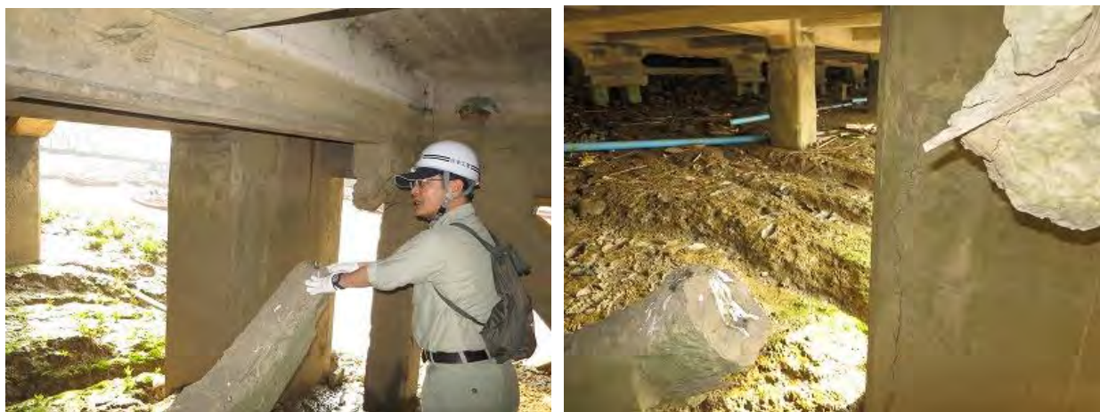
写真 3.2 Nan Thi Da 3 の補修箇所近傍の部材損傷状況
