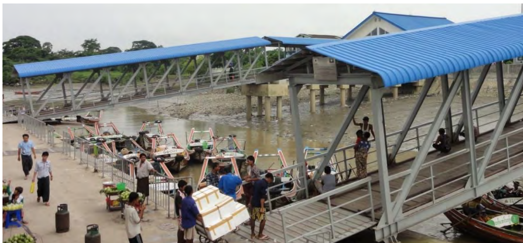
写真 2.3 可動式鋼製渡橋（東側および西側）
