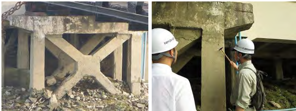
写真 3.1 Nan Thi Da 3 の全景と補修箇所調査状況
