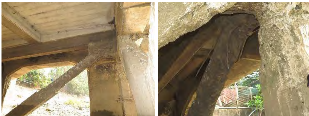
写真 3.4 Nan Thi Da 4 の補修箇所近傍の部材損傷状況
