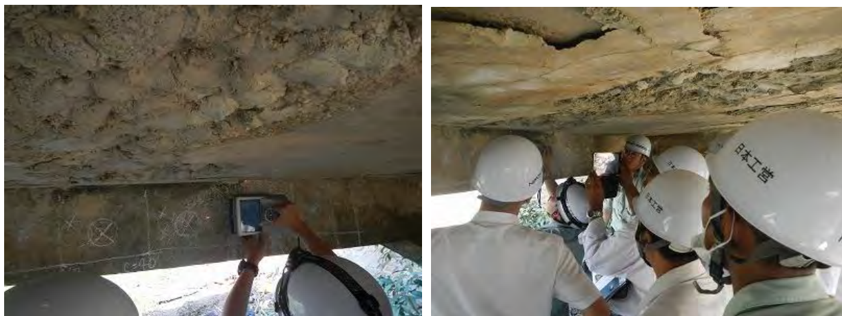
写真 3.20 鉄筋探査機によるコンクリート中の鉄筋位置の把握状況
