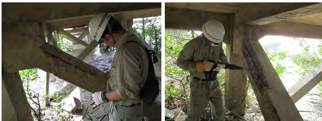
写真 3.21 栈橋の劣化状況およびコンクリートのはつり作業の状況
