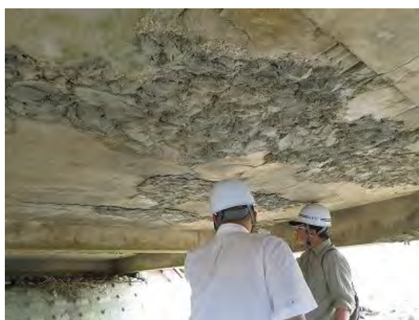
写真 3.13 Kaingdan Jetty 1 の全景と補修部再劣化箇所
