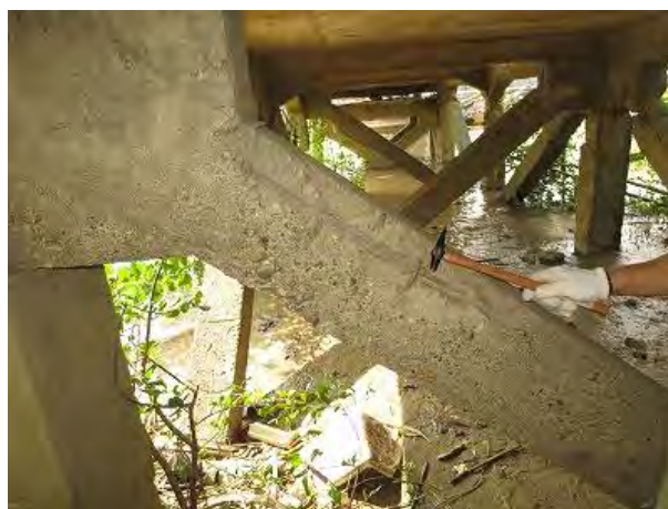
写真 3.14 Wadan Jetty 6 の全景とひび割れ鉄筋露出箇所
