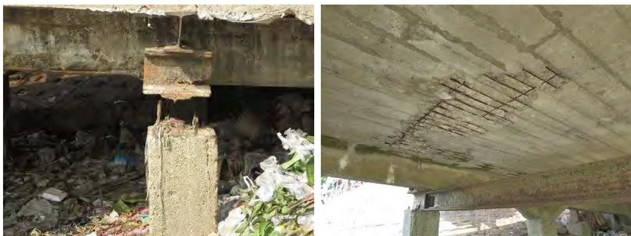
写真 3.8 Sin Oh Dang 2 の損傷状況（左：柱部材の欠損、右：下面の鉄筋露出）
