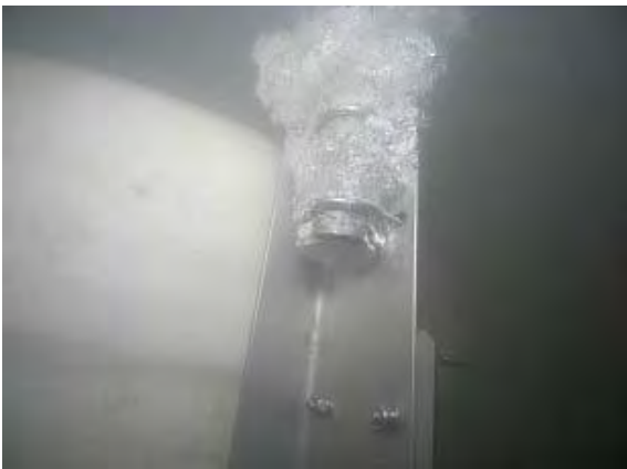
緊急排気状況
