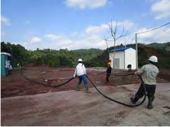
エアホース法面部保護管挿入
