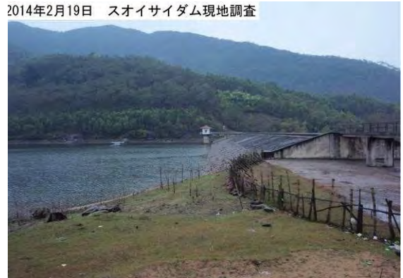
2014年2月19日 スオイサイダム現地調査
