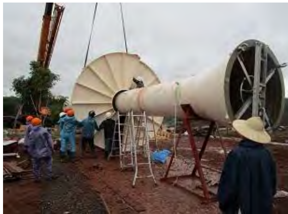
下部案内板取付
