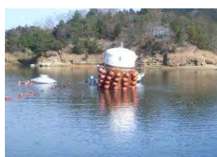
ダム湖での本体設置作業
