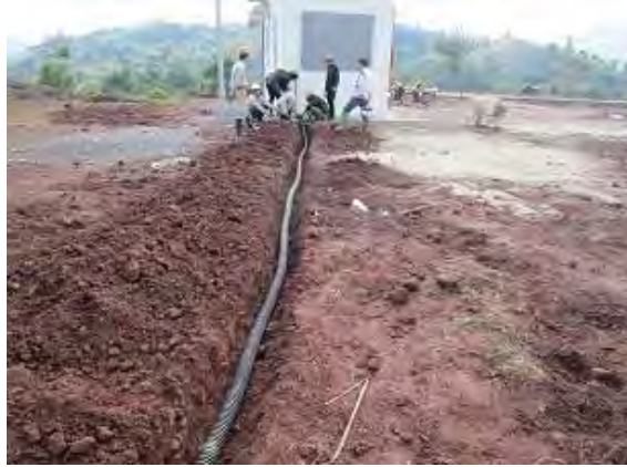
エアホース埋設
