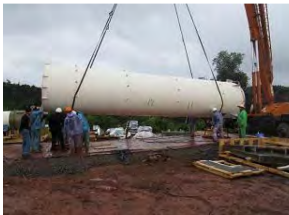
外筒荷下ろし
