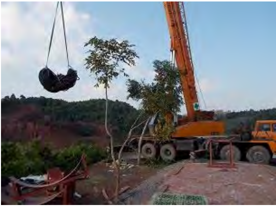
エアホース接続完了 作業船上へ
