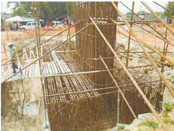
図 4.3.12 対策実施後の橋脚の鉛直鉄筋
