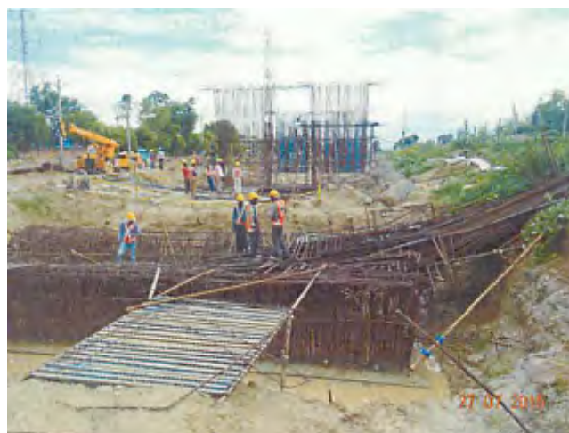
図 4.3.11 支保工が崩れ倒壊した鉛直鉄筋
