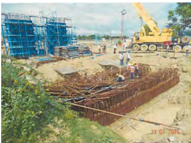
図 4.3.11 支保工が崩れ倒壊した鉛直鉄筋
