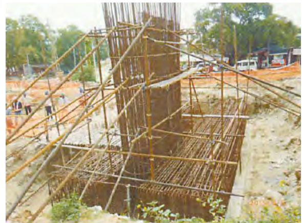
図 4.3.12 対策実施後の橋脚の鉛直鉄筋
