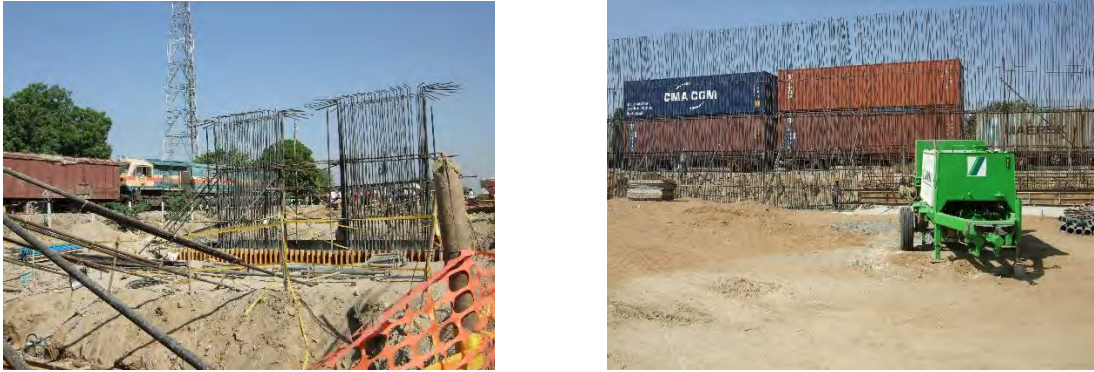
図 3.2.6 既存鉄道線近接工事 (2015年10月23日撮影)
