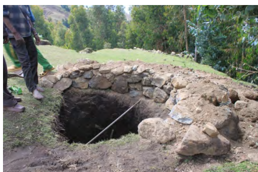
設置作業中のトイレ (Argin)
