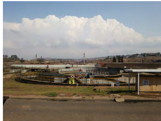
E 下水処理場
