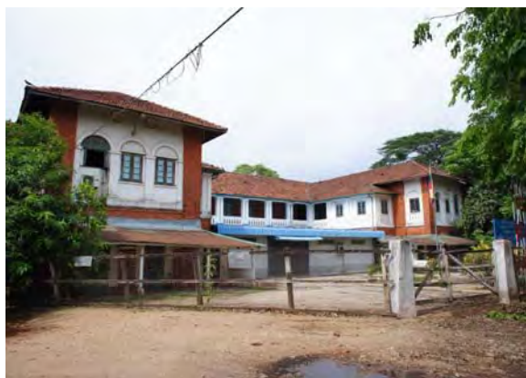
No. 1 建設予定地。1940年代に建設された既存施設を活用することがミャンマー政府より提案された。1階を口蹄疫診断施設に利用する。
