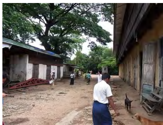
No. 2 建設予定地。No. 1の既存建物の北側。左右両者の既存建物を解体し、口蹄疫ワクチン製造施設を新設する。
