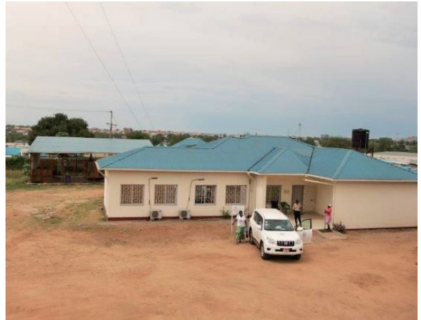
SSTVR 敷地内に設置されたプロジェクト事務所 (手前) と供与されたジェネレーター (奥)。二つの会議室と編集用 PC が設置された部屋が併設されており、SSTVR 職員の会合の機会が増えた。以前は、木陰に集まって会議をしていた。
