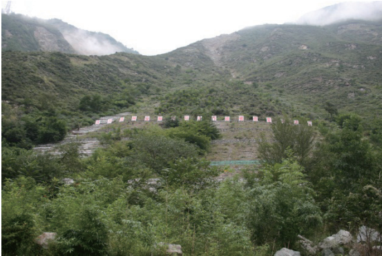
汶川県綿スー鎮プロジェクト 2011-2013 年試験施工地
