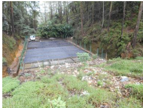
浸出水処理施設
