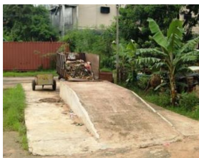
写真:市場(左)及び廃棄物管理センター内(右)に設置されている小規模中継基地
