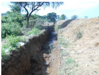
野生象の侵入防止トレンチ
