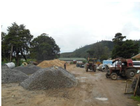
WS内に保管されている道路建設用資材
