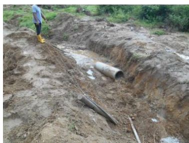
象により破壊された電気フェンス
