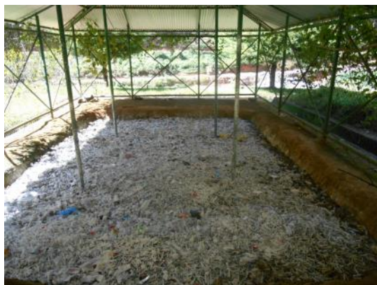
写真: 医療廃棄物用処分施設
