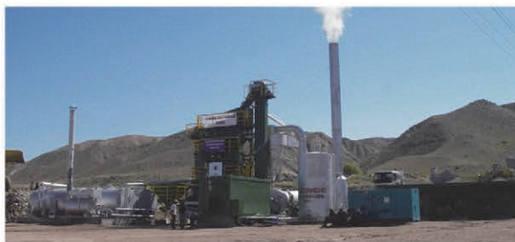
15. アスファルトプラント
