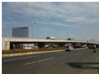
Dong Nai Bridge Projectにて、2014年に一方通行のフライオーバーが完成 (Phase-1)
