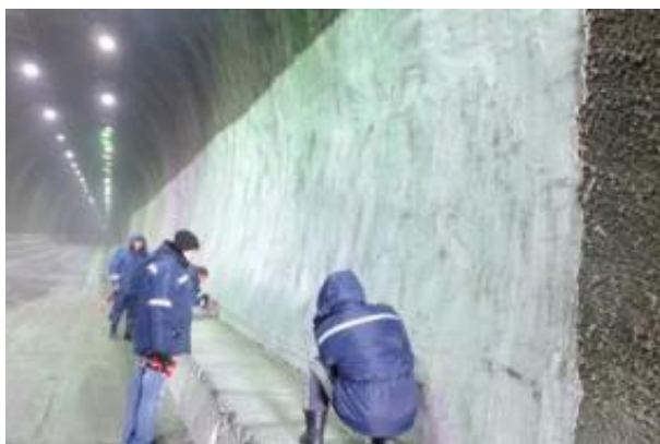
写真 2-13 トンネル点検の様子(1)
