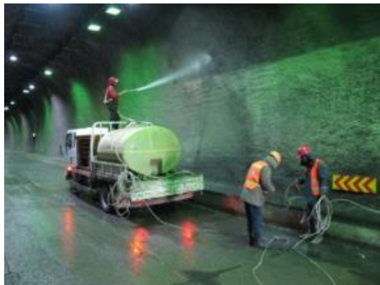
写真 2-12 壁面の清掃状況
