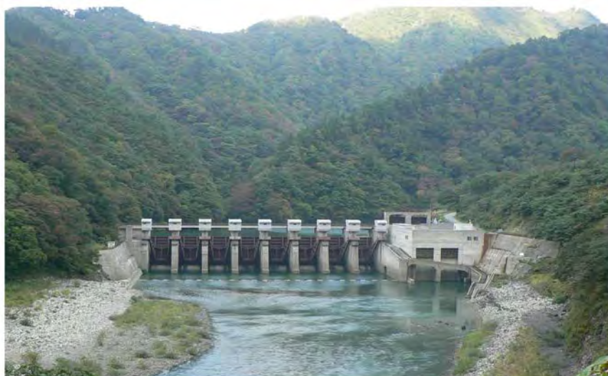
Figure 7.7.6 Exemple d'une centrale hydroélectrique de basse chute typique (15,7MW) au Japon
