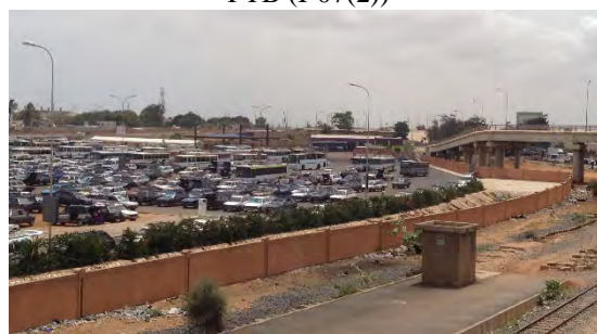
Plan du site de construction de la bretelle d'accès dans le Sud (I-09(1b)) et de la bretelle de sortie (I-09(2))
