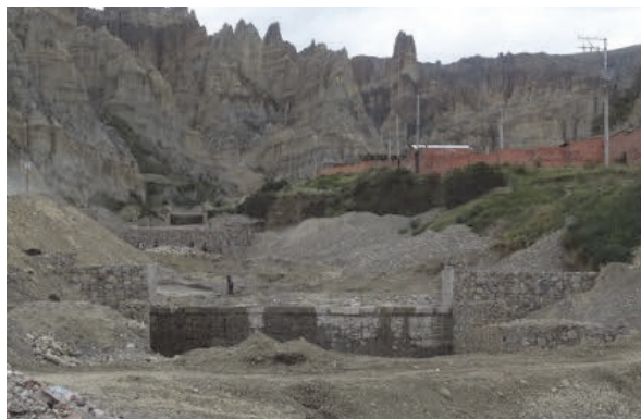
Dique de gaviones para control de erosión
