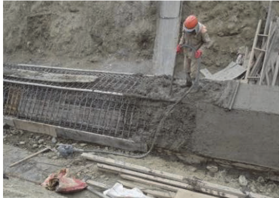
Alcantarillado para drenaje
