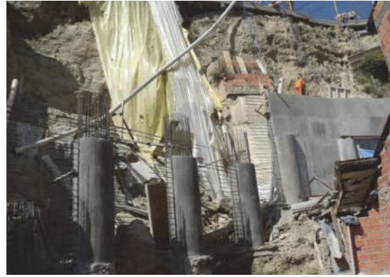
Muro de contención (Pilote + Muro)
