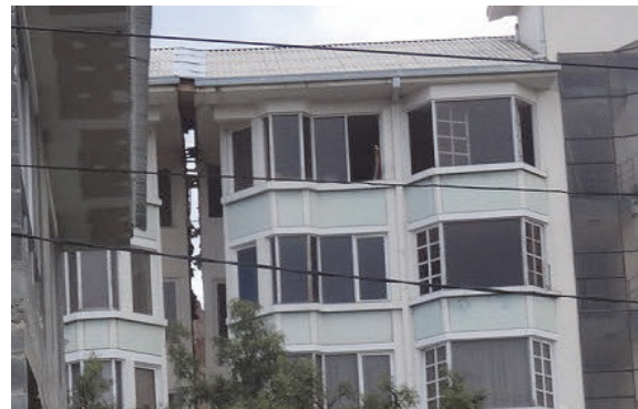
Desnivel de 50 cm en vivienda por deslizamiento
