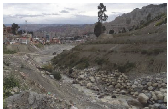
Protección de mampostería susceptible a erosión
