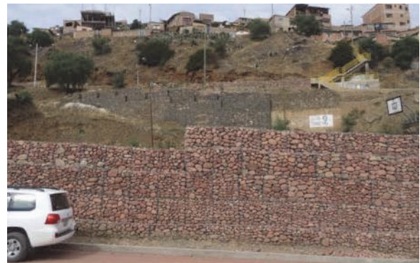
Gaviones en Cochabamba
