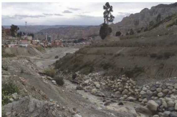
浸食を受けやすい石積護岸
