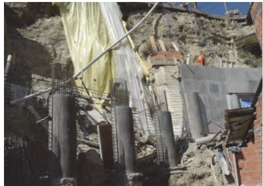
土留め壁（杭と壁の一体構造）
