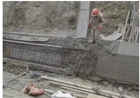
暗渠工排水工
