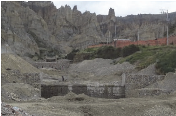
石積工による砂防堤
