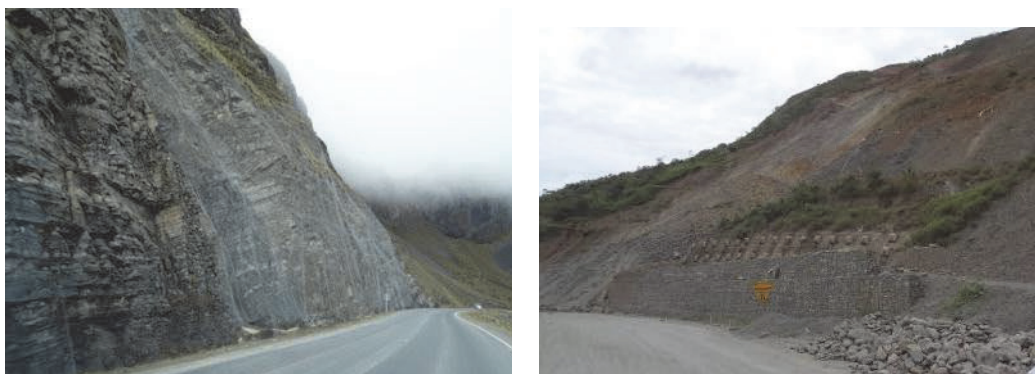
図 3.3.4 国道3号線の落石防護ネット（左）と斜面崩壊現場の対策状況
