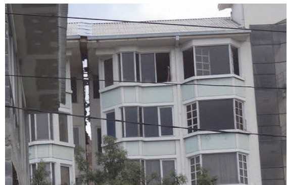
地すべりによる建屋の段差 50cm
