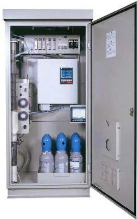
图 2-4 红外线烟气分析仪（非分散红外线吸收法）
