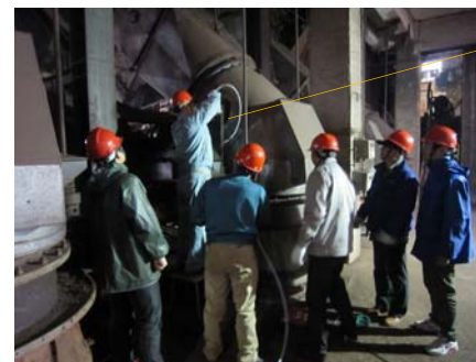
照片：开检测孔
