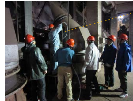
写真:測定孔を開ける場面
