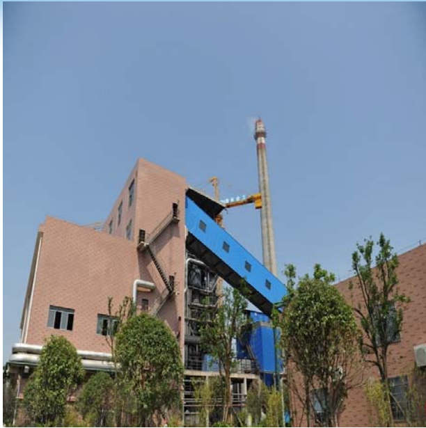
熱併給発電所の煙突
