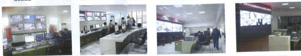
新余钢铁中控 宝钢不锈钢中控 南钢烧结中控1期 南钢烧结中控2期
