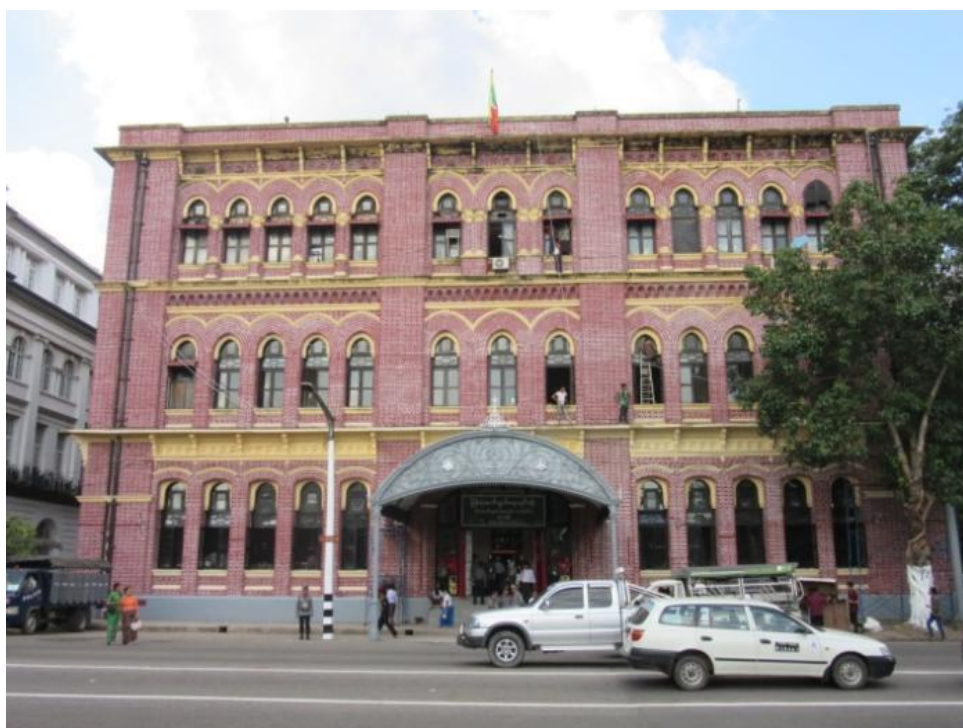
図表 2-3 : Yangon General Post Office 正面写真
