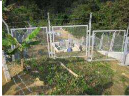
水力発電機の据付工事 (2014年12月)
