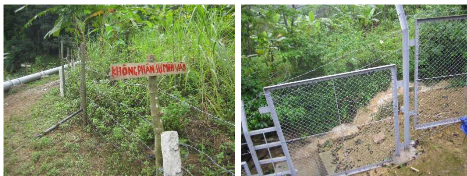
図 44 防護フェンスと立入禁止の看板
