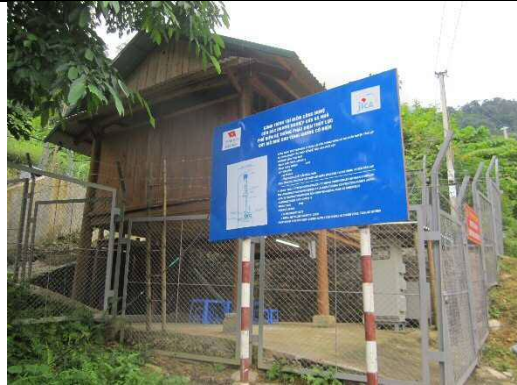
見学者用の看板の設置 (2015年11月)
