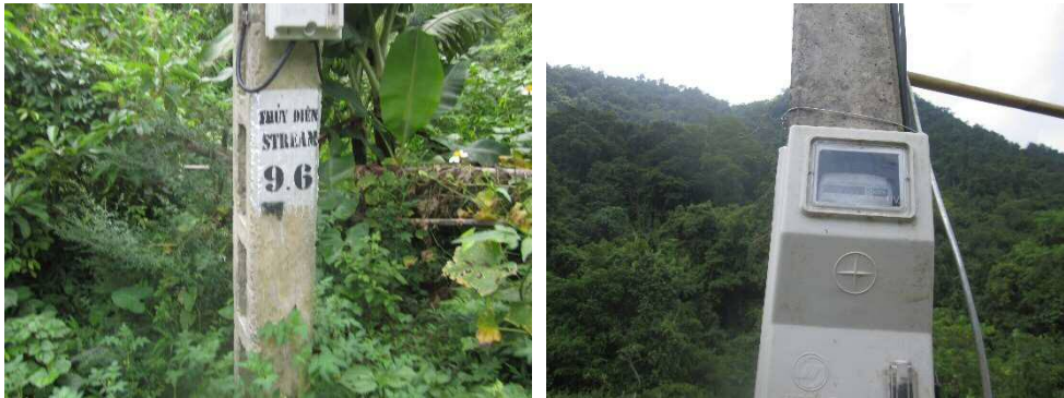
図 27 各世帯に配置された電力量計
