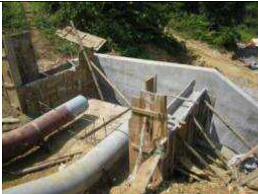
土木工事の状況(工事途中) (2014年10月)
