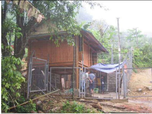
水力発電設備の管理小屋の建設 (2015年4月)
