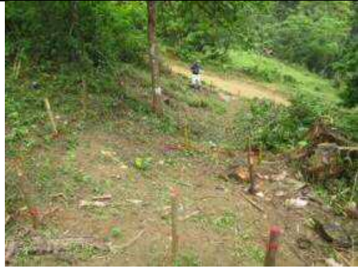
水力発電機の設置地点付近 (2014年4月)
