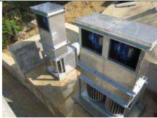
水力発電機の据付完了(下流部) (2014年12月)
