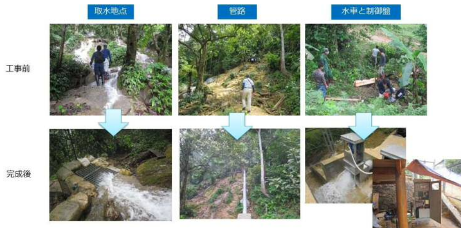
図 19 水力発電機の設置工事写真 (工事前・工事後)
