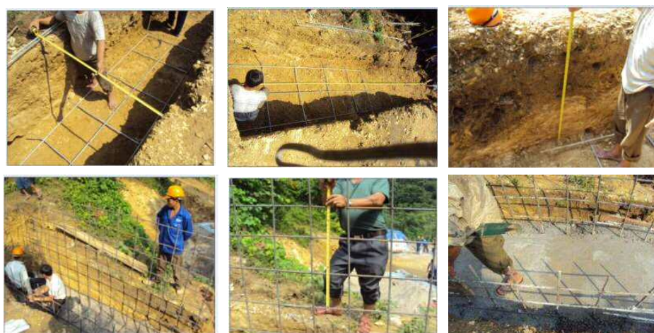
図 20 土木工事の品質チェック（掘削）
