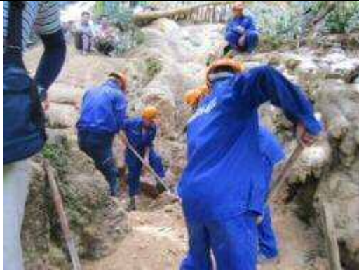
水力発電の取水地点付近の工事状況 (2014年9月)
