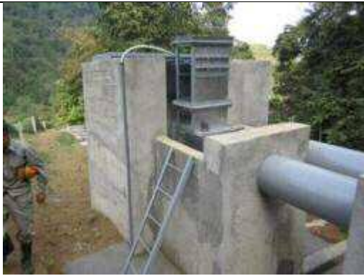
水力発電機の据付完了(上流部) (2014年12月)
