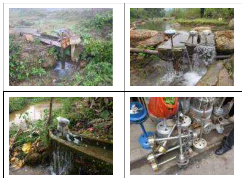
図 7 ベトナムで使用されているピコ水力発電設備
