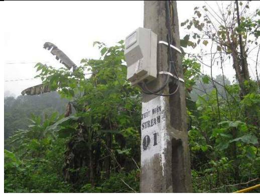
ホアビン省予算での13世帯への電柱敷設 (2015年4月)
