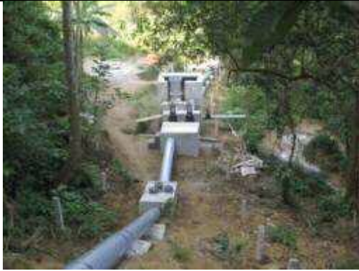
水力発電機の据付工事 (2014年12月)
