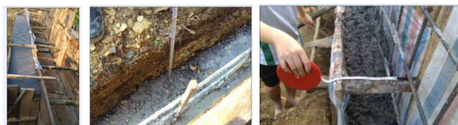
図 21 土木工事の品質チェック（鉄筋）
