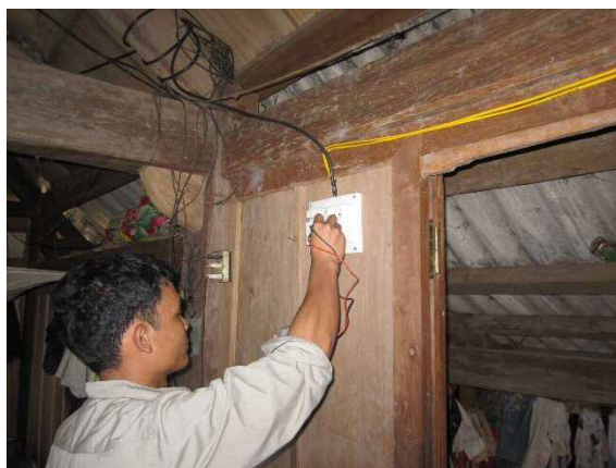
図 30 各世帯への正常な送電状況の確認
