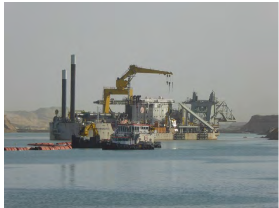
現場視察(新規バイパス南側) JICA プロジェクトチーム(2015/2/4)
