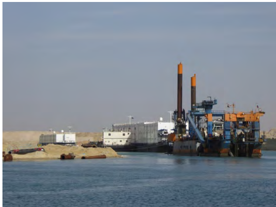
現場視察(新規アクセスチャンネル) JICA プロジェクトチーム(2015/2/4)
