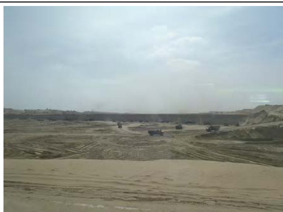
現場視察(新規バイパス) JICA プロジェクトチーム(2014/11/11)
