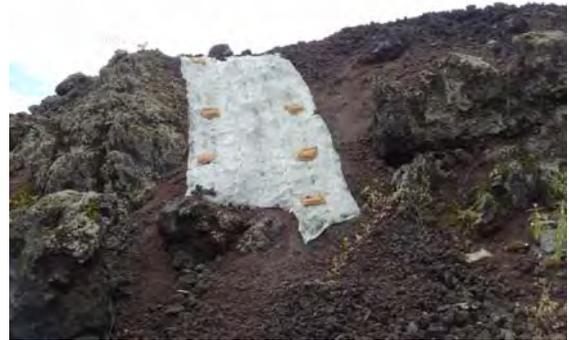
写真 54 種バッグ設置状況（2回目）
