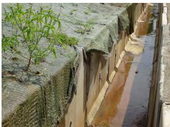
写真 32 B 工業団地排水路の土砂流出状況の比較 (SP-60) (2015 年 3 月)
