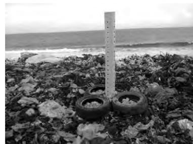
設置されたガス抜き管
