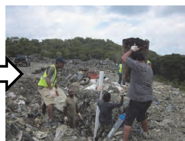
パイプの設置
