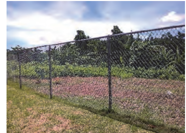
境界フェンス
