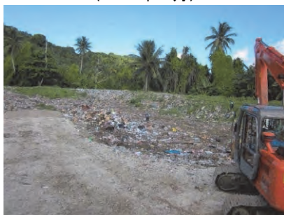
処分場改善中 (2013 年 7 月)
