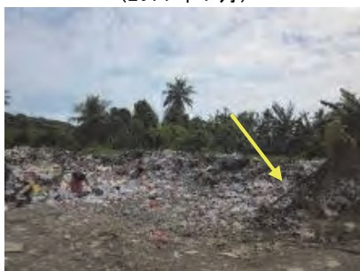
フェンスが一部倒れている (2015 年 1 月)
