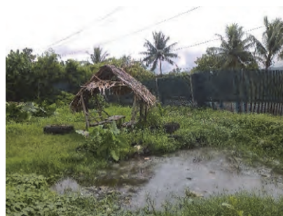
浸出水処理の状況
