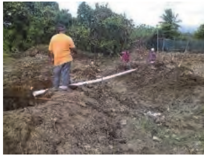
パイプの設置
