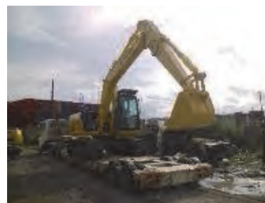
到着したばかりの重機の1台
