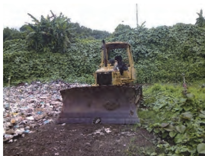
転圧用のブルドーザ
