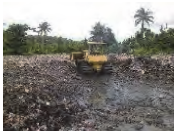
ブルドーザ転圧状況
