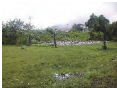
覆土が実施された処分場
