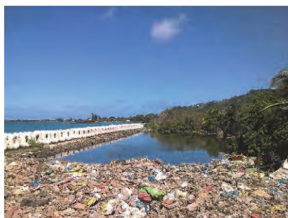
マリーナ処分場予定地現況
