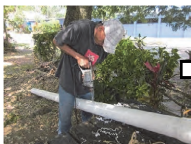
PVCパイプに穴をあける作業
