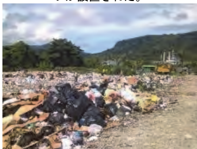
コンパクターが不調のため、転圧が2か月ほど実施さ れていない。重機メンテの問題も大きな課題である。
