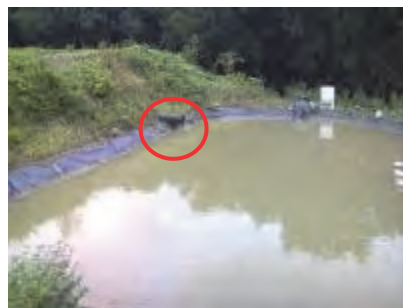
高水位時の浸出水集水池 浸出水集排水管との高低差は確保されている
