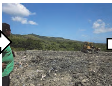
ブルドーザーによる作業
