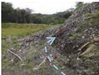
設置された仮設水路（矢印） これだけでオーバーフロー回避の効果が十分にある
