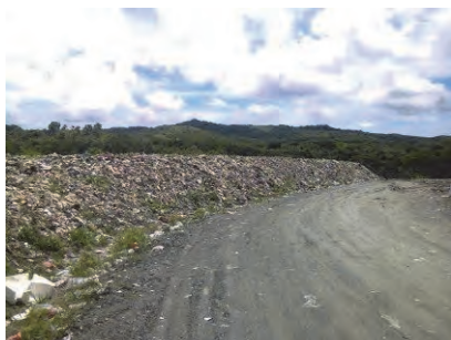
成形された既存処分場
