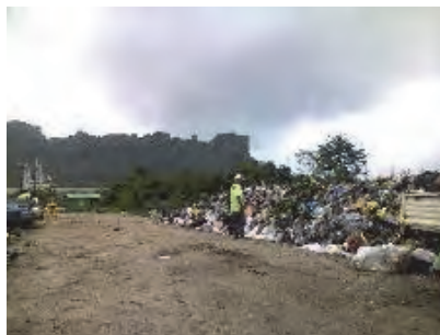
転圧は約1年間実施されなかったが、修理完了後 コンパクターにより転圧再開の見込み
