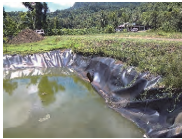
浸出水貯留池
