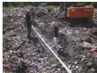
パイプと砕石の設置
