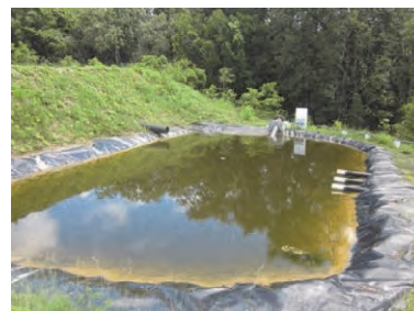
浸出水ポンド
