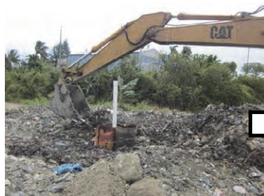
ガス抜き管周囲の覆土
