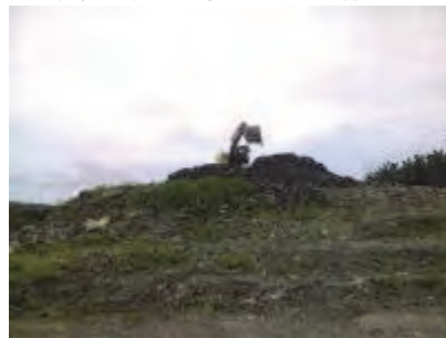
既存処分場エリア ごみの移動・整形はゆっくりと進んでいる
