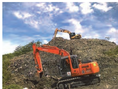
アプローチ道路と転回スペースのための工事
