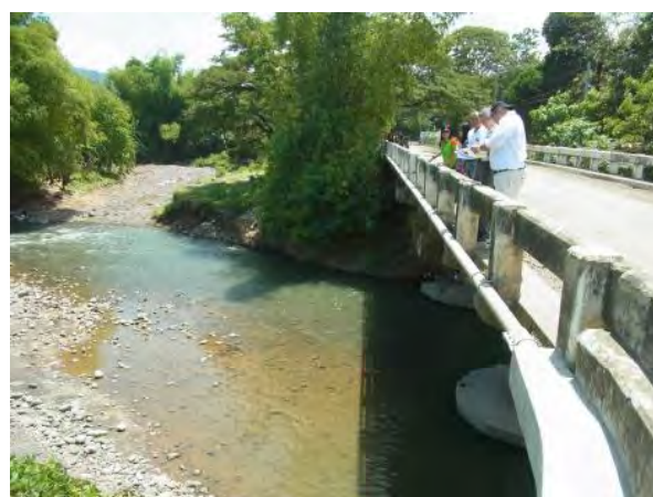
水位計設置予定地の現地踏査
