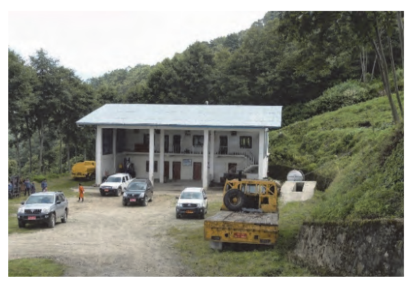
CMU カンマ支所（タシガン県） 整備工場及び駐機場
