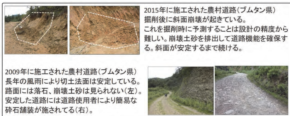
図 2-8 建設直後の農村道路と数年を経た農村道路
