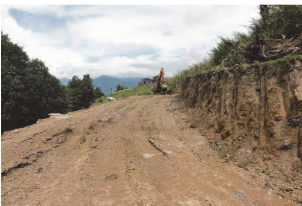
農村道路建設状況（タシガン県） 第二次農村道路建設機材整備計画で 調達されたエクスカベーターにて施工中
