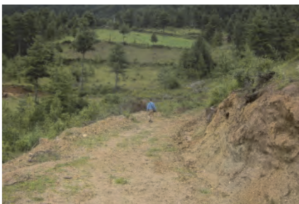
農村道路（ブムタン県） 竣工後一年経過した農村道路 路面・切土が安定してきている
