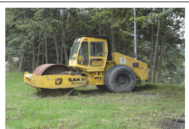
CMU カンマ支所（タシガン県） 振動ローラー 第一次農村道路建設機材整備機材で調達
