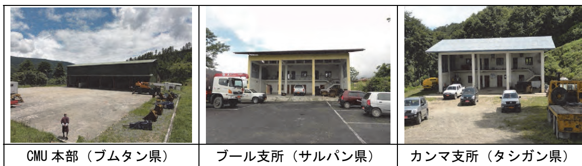
図 2-3 CMU 本部、各支所のワークショップ建屋
