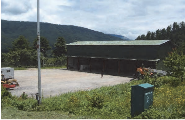
CMU 本部（ブムタン県） 整備工場及び駐機場
