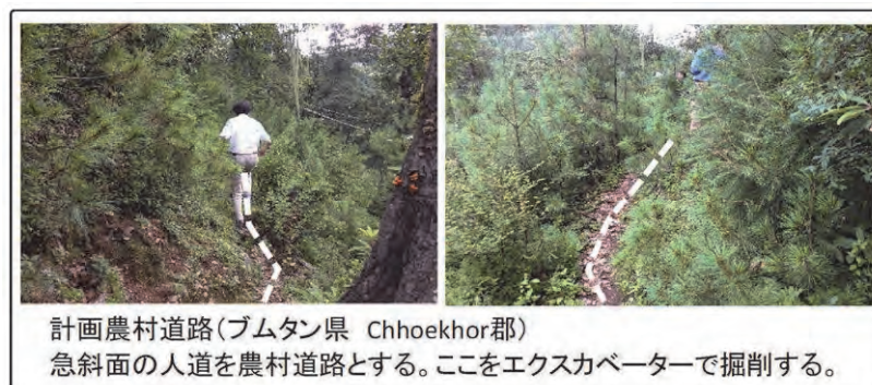
図 2-9 計画農村道路の現場
