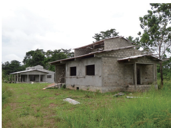
建設途中のリサーチステーション
