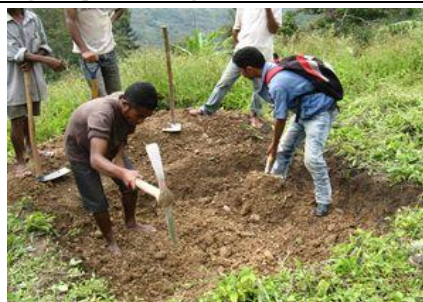
Dig a pit
