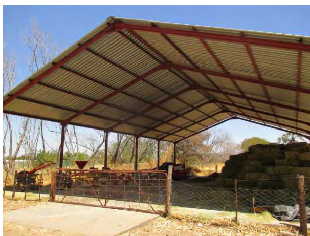
供与機材等を保管するための建屋（刈取り機、脱穀機や精米器等を保管している）
