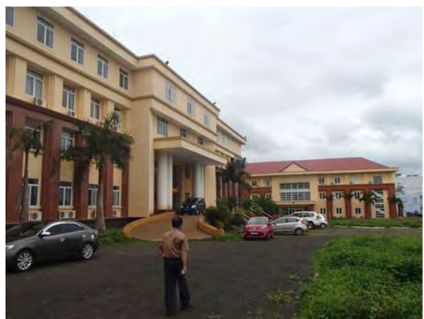
タイグエン衛生疫学研究所（新施設）の外観
