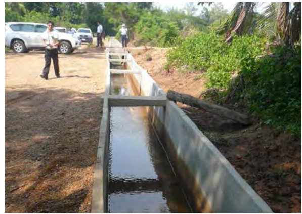
改修後の幹線水路 (Xaibouly 郡 Tonhen 地区)
