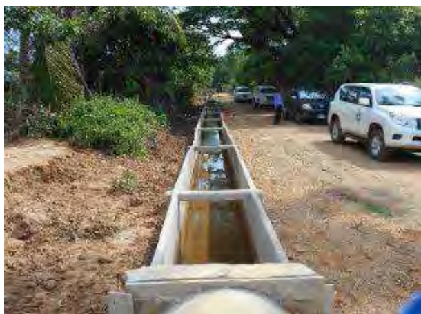
農民施工による幹線水路 (Xaibouly 郡 Tonhen 地区)
