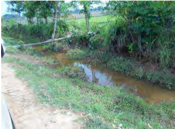
改修前の現況の幹線水路 (Xaibouly 郡 Tonhen 地区)
