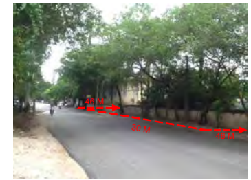
1- MỞ RỘNG ĐƯỜNG NGUYỄN HOÀNG TÔN
