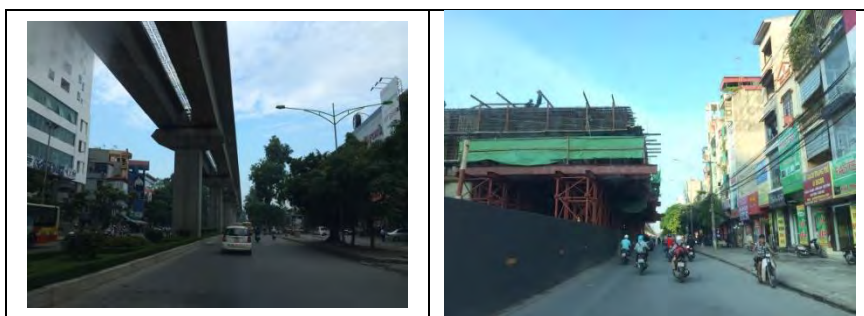
Hình 2.6.2 Hình ảnh về công trường xây dựng Tuyến ĐSDT số 2A
