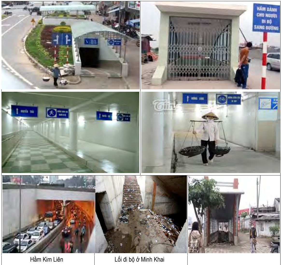
Hình 2.2.4 Hiện trạng hầm chui
