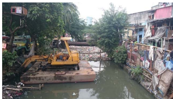
図 3.2.12 排水路内での作業
