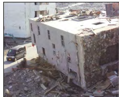
図 5.1-8 津波波圧による被害の例
