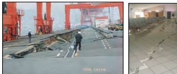
図 5.1-5 地震による岸壁の被害(左)、管理棟の床面のクラック(右)
