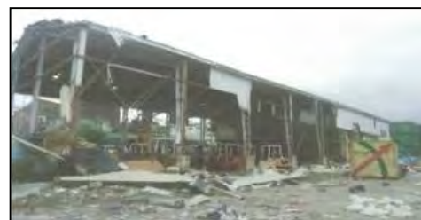
図 5.1-4 高潮による建物側壁の被害
