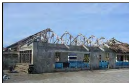
図 5.1-2 旅客待合所の屋根の被害
