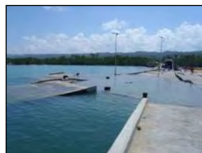
図 5.1-6 液状化による岸壁背後の被害
