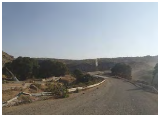
Dera-Sire 間の道路の路面の様子
