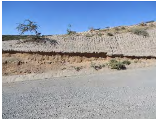
古土壌を挟む軽石質凝灰岩から構成される。 Boru川（L-AB19）
