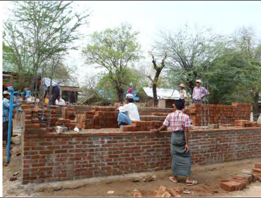
写真-7: NGO支援による嵩上げ給水タンクの建設状況 (Nyangoon タウンシップ Makyi Zunt村)。熟練工を除き、村落住民は無償で建設に参加。
