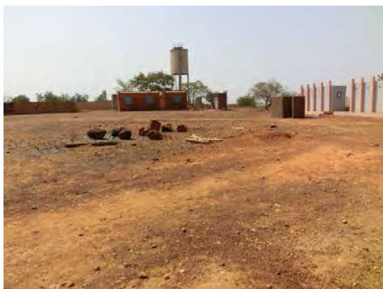
写真-9 Mogtédo 村のレベル 2 給水施設
