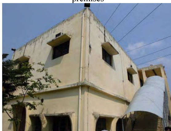
(d) Existing Control Building
