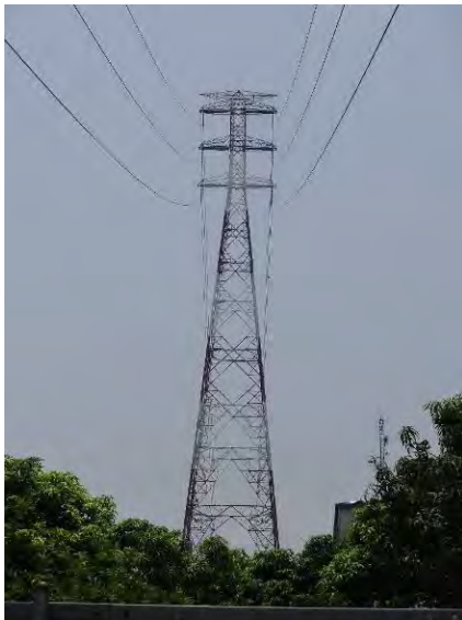
既設 230 kV 送電線 (左)河川横断鉄塔、(右)引留鉄塔
