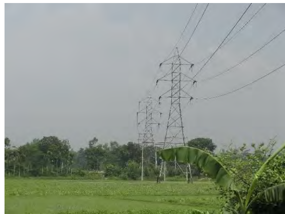
既設 132 kV 送電線
