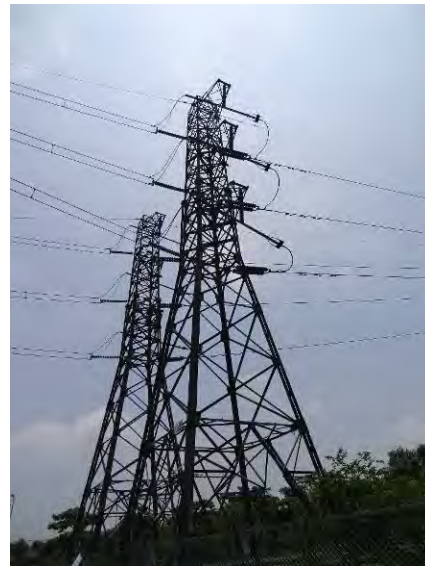
既設 230 kV 送電線 (左)河川横断鉄塔、(右)引留鉄塔
