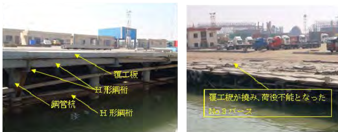
図 5.5-17 アブ・フルス港既存岸壁構造
