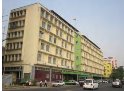
商業省ヤンゴン事務所
