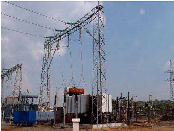
**132/33 kV アポ変電所構内にある焼失した変圧器**
