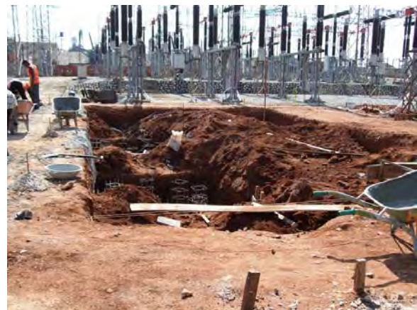
据付中の電力用コンデンサの様子（カタンペ変電所）
