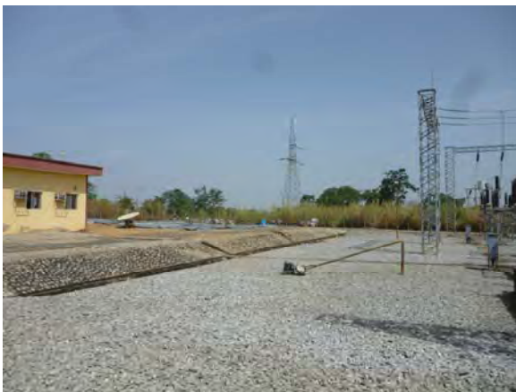
132/33 kV ケフィ変電所内 機材据付予定地
