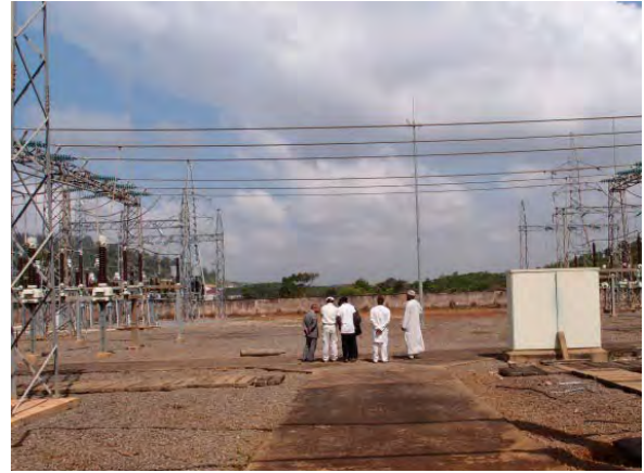
132/33 kV アポ変電所内 機材据付予定地
