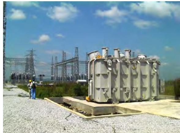
据付中の分路リアクトルの様子（グワグワラダ変電所）
