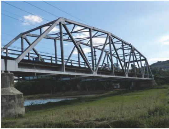
Buntun Bridge (トラス橋) 1957年建設されたトラス橋である。主構造は健全である。
