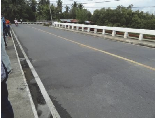
Ibo 橋 TCP-II で実施した橋梁補修パイロットプロジェクトサイト。
