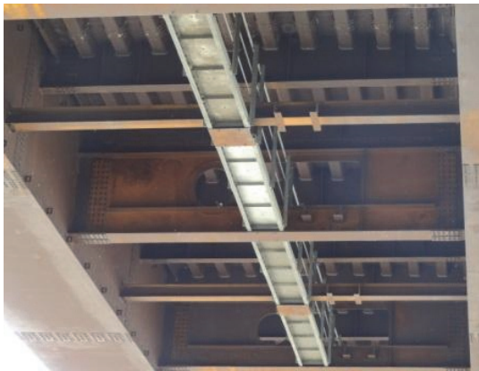
同上 桁下面には、点検用通路が設置されている。
