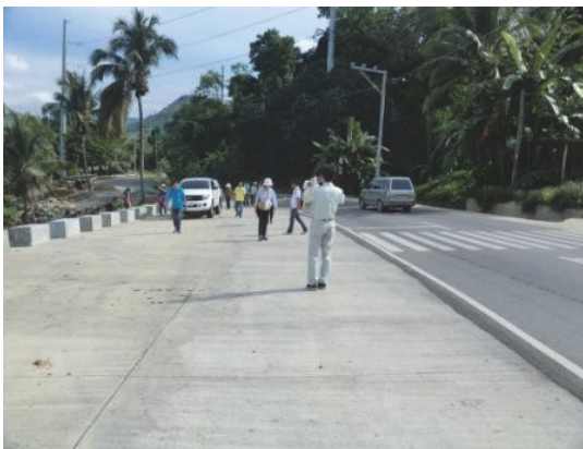
TCP-II で実施した道路斜面对策工パイロットプロジェクトサイト。(ナガウリン道路)
