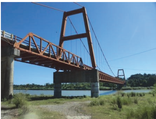
マガピット橋 DPWH において 2011 年補修を実施した。
