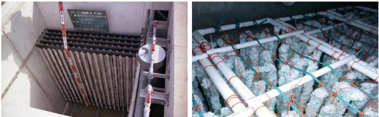
図 4.9 反応槽内へのバイオコード設置イメージ
