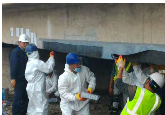
Фото 2.4.43 CFRP-ээр хүчитгэх аргачлалын барилгын ажилд технологийн дэмжлэг үзүүлж буй байдал
