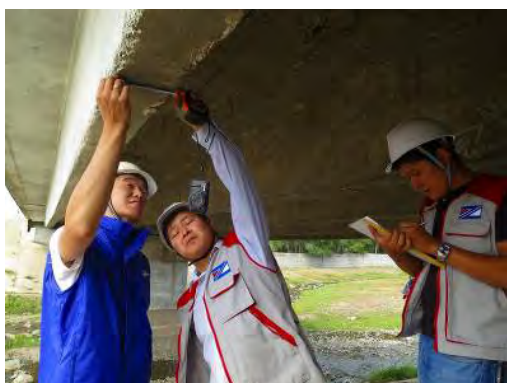
Фото 2.4.3 НАЗГ бие дааж үзлэг хийж буй байдал
